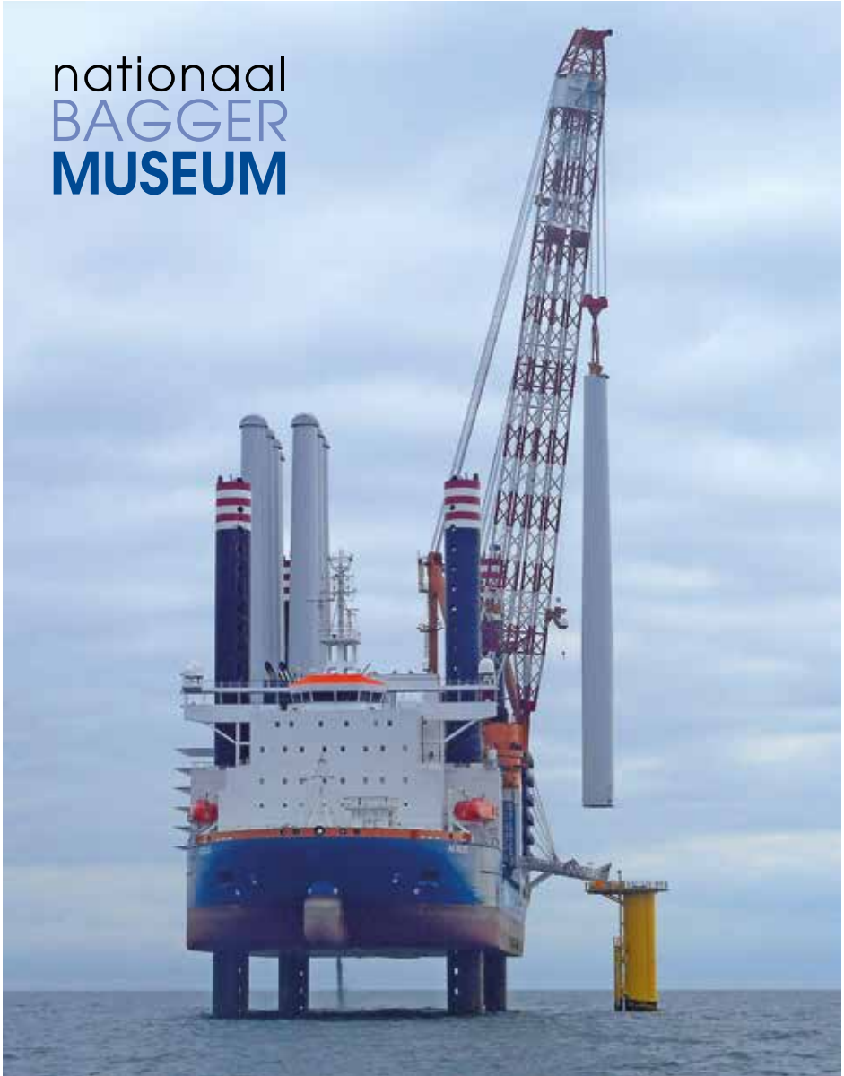
Offshore installatieschip "Aeolus", Van Oord
